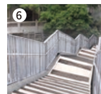
▲平常很少開放，可由二樓直接通往六樓的走火鐵梯
